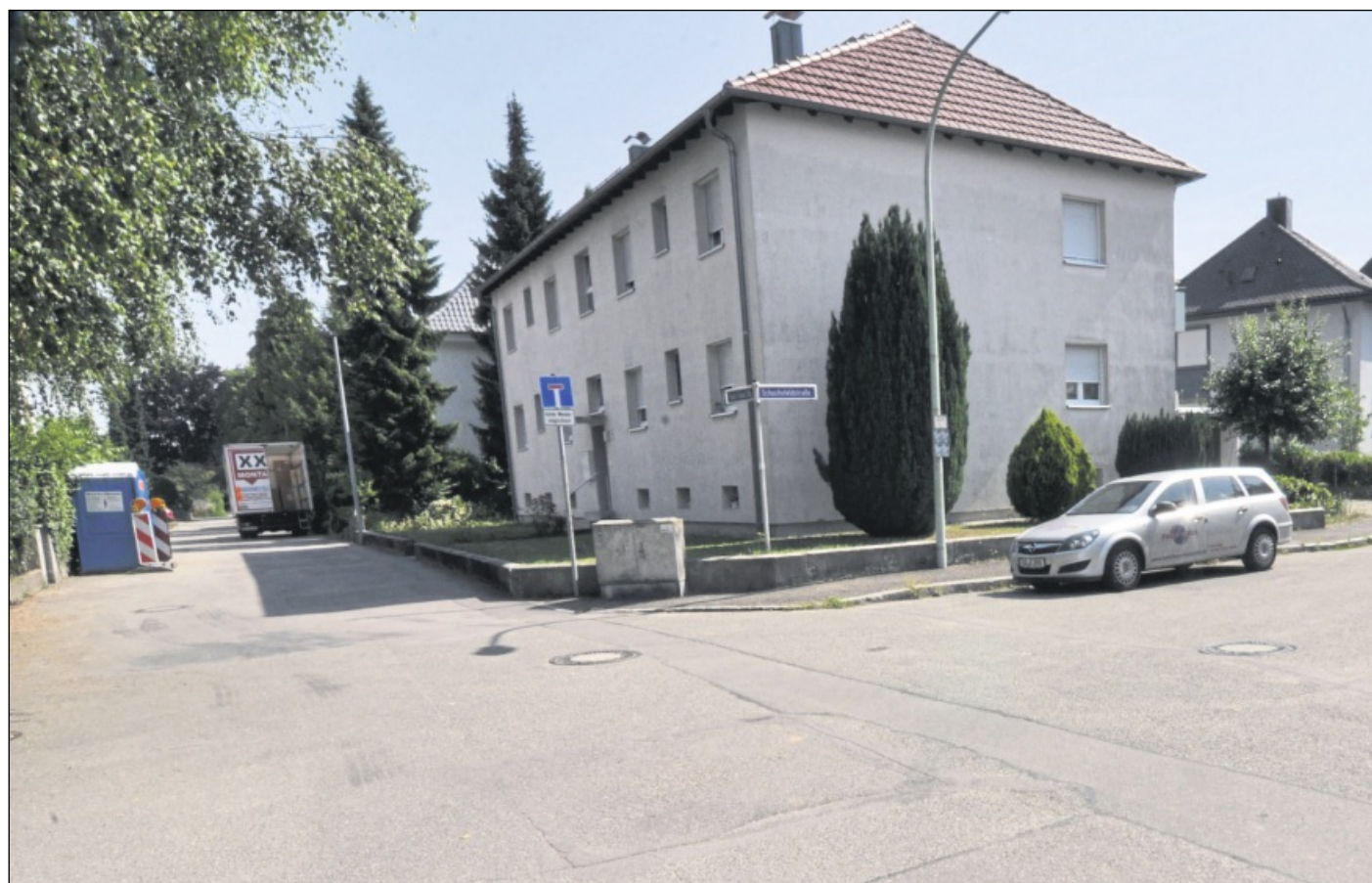
SACKGASSE: Der nördliche Abschnitt der Karl-Fanz-Straße zweigt von der Schuchsfeldstraße ab und endet nach 145 Metern an der Robert-Koch-Straße. Die kurze Strecke ist in einem schlechten Zustand. Foto: Margull
